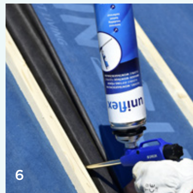
Moussage entre panneaux de toiture avec Uniflex
