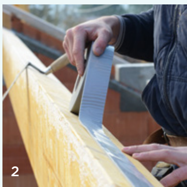
Pose d'une bande de protection Unimousse
