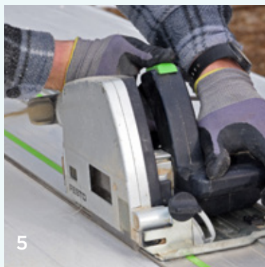
Découpe des panneaux de toiture
