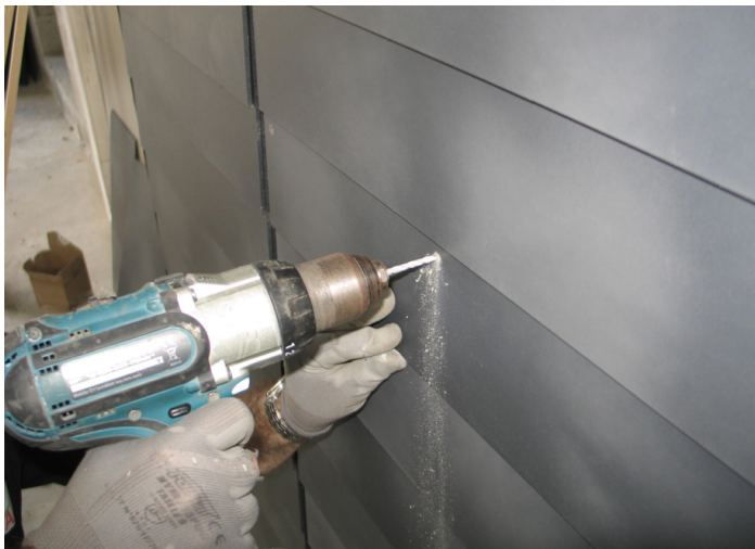
Percement de la dernière ardoise à changer.
