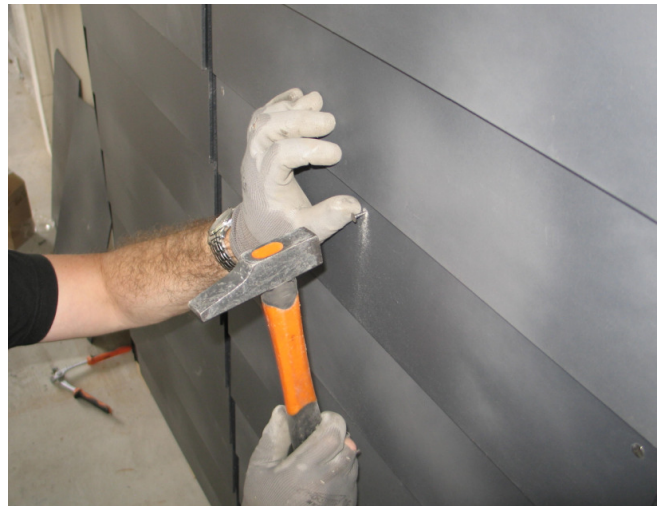
Pose des clous pour fixer l'ardoise.
