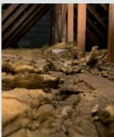
Perte d'efficacité de l'isolant.
