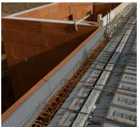
Plancher bas sur terre-plein avec dalle pleine
