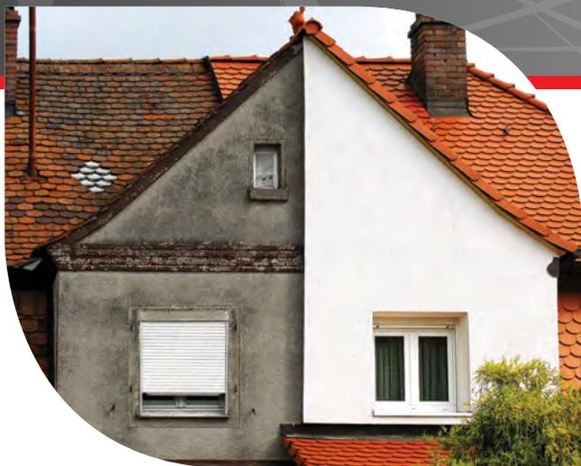
Le Système EDIL-Therm® est un procédé d'Isolation Thermique par l'Extérieur (I.T.E.) par enduit mince avec des plaques en polystyrène expansé (PSE) ou en Laine de Roche.
