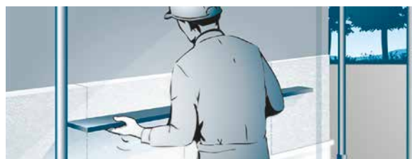
Fig. 6 : Contrôle de la planéité
