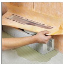
=> 2. Mettre en place le corps de caniveau
