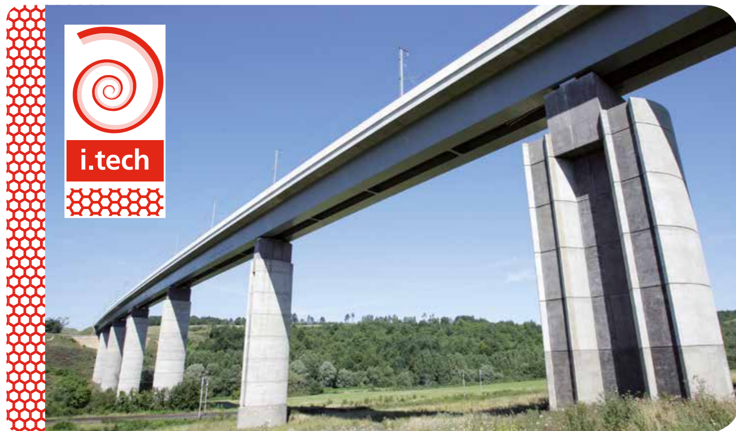
Viaduc de Jaulny LGV Est (54) - Architectes : Fabrice Neel et Brigit de Kosmi.
