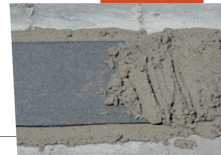
Pose d'une coupure de capillarité entre 2 couches de mortier
