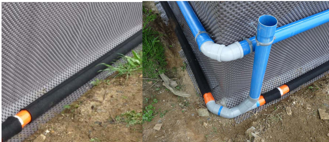
Figure 7 : Exemples d'installation du BatiFIBRE®-SN4 sur vide-sanitaire
