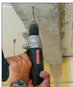
Vissage direct dans béton
