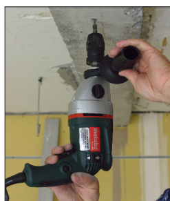
Perçage Ø 5 mm
