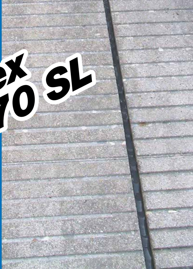
**Mapeflex PU 70 SL** résiste à une température de - 30°C à + 70°C avec une résistance ponctuelle allant jusqu'à + 150°C.
