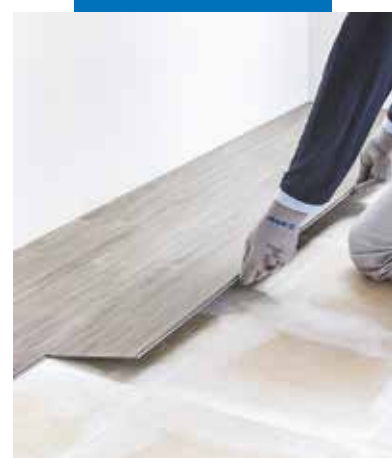
Pose de LVT Clipsable sur ancien carrelage ragréé avec Planiprep 4 LVT
