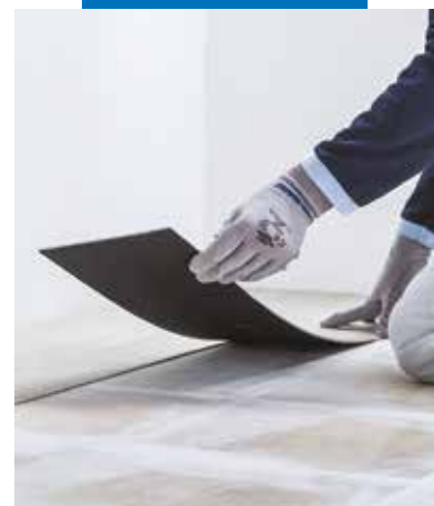
pose de LVT sur ancien carrelage ragréé avec Planiprep 4 LVT
