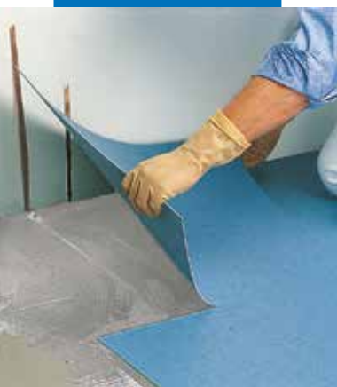
Pose de dalles en PVC conducteur avec Ultrabond Eco V4 SP Conductive
