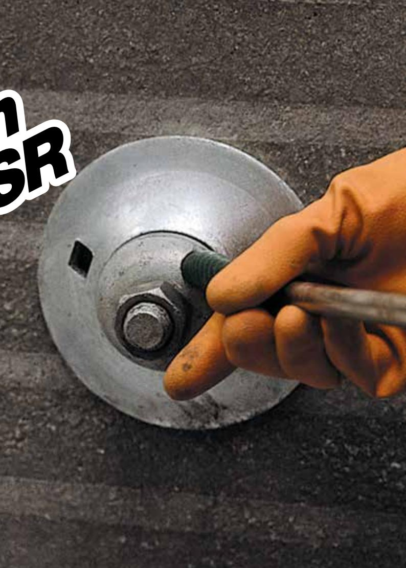
représente un moyen efficace pour ancrer facilement les boulons et les tirants utilisés durant les opérations de consolidation, y compris dans le cas où ils sont soumis à de fortes tensions durant la mise en œuvre.
