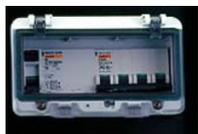
**R03B** Ce coffret inclut le compteur horaire, l'interrupteur différentiel, les prises et le disjoncteur thermique
