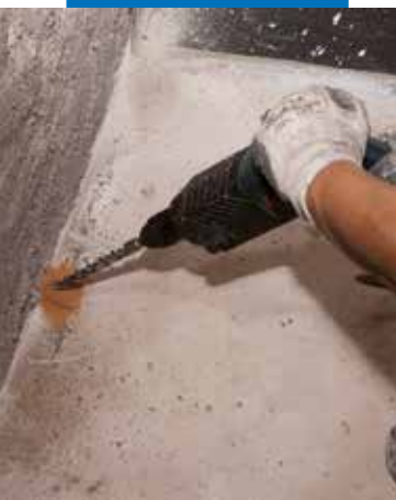
Réalisation des trous
