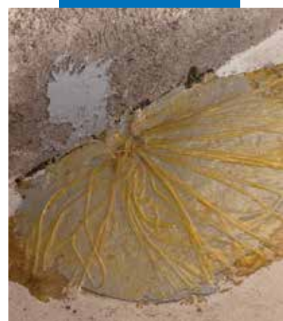
Imprégnation de MapeWrap FIOCCO
