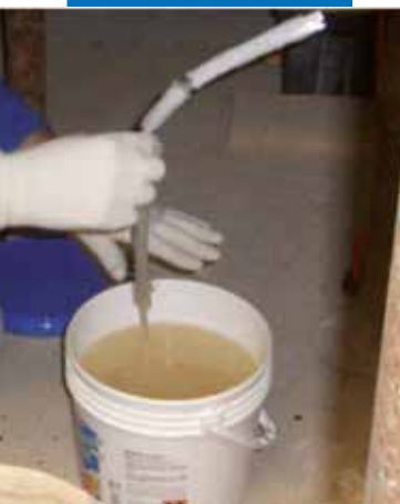
Imprégnation d'une portion de MapeWrap FIOCCO
