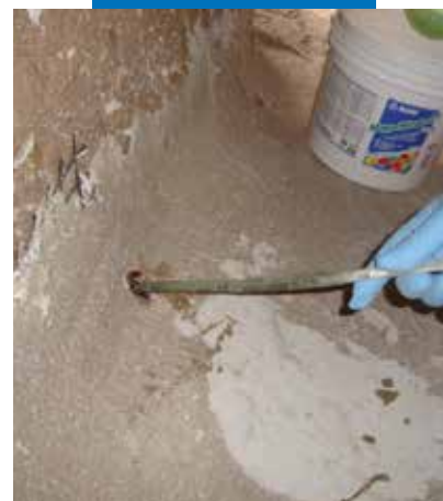
Insertion de MapeWrap FIOCCO dans le trou
