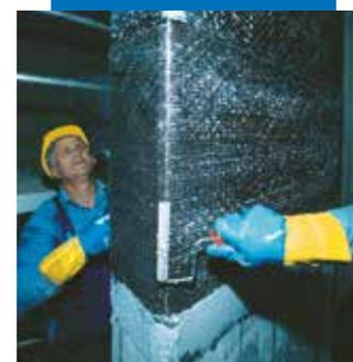
Marouflage de MapeWrap C Uni-AX dans MapeWrap 31
